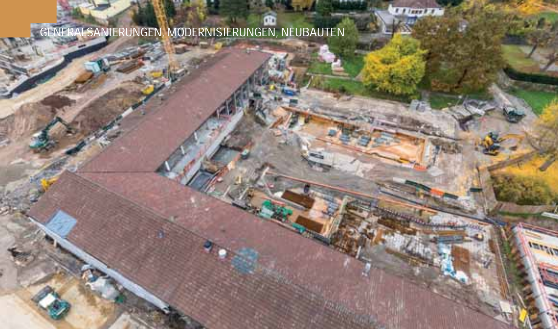
Entkernen, Sanieren, Auffrischen - das altehrwürdige »Neuner« bekommt ein Facelift. © Bäderbetriebe Stuttgart
